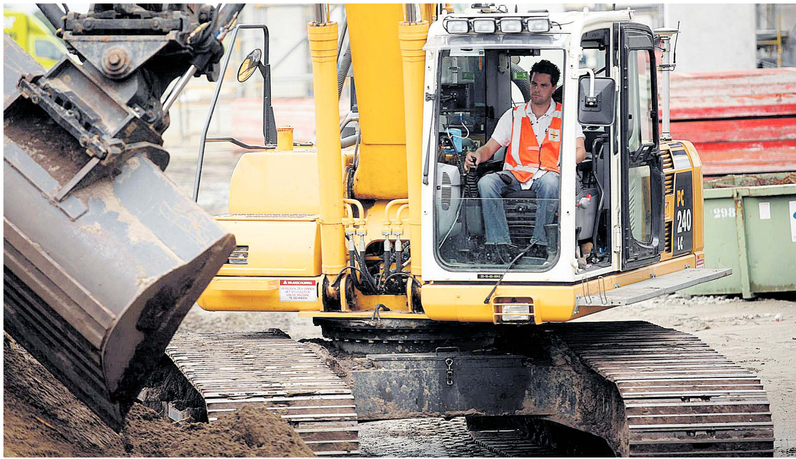
Bagger beim Aushub: Im Bauprozess stecken viele versteckte Risiken, die Bauunternehmer kalkulatorisch berücksichtigen müssen. FOTO: DPA
